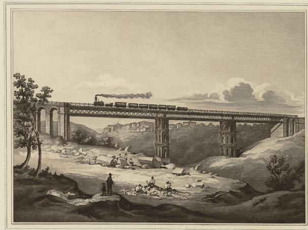
PONTE DI FERRO DELLA PIO-LATINA presso Velletri.
