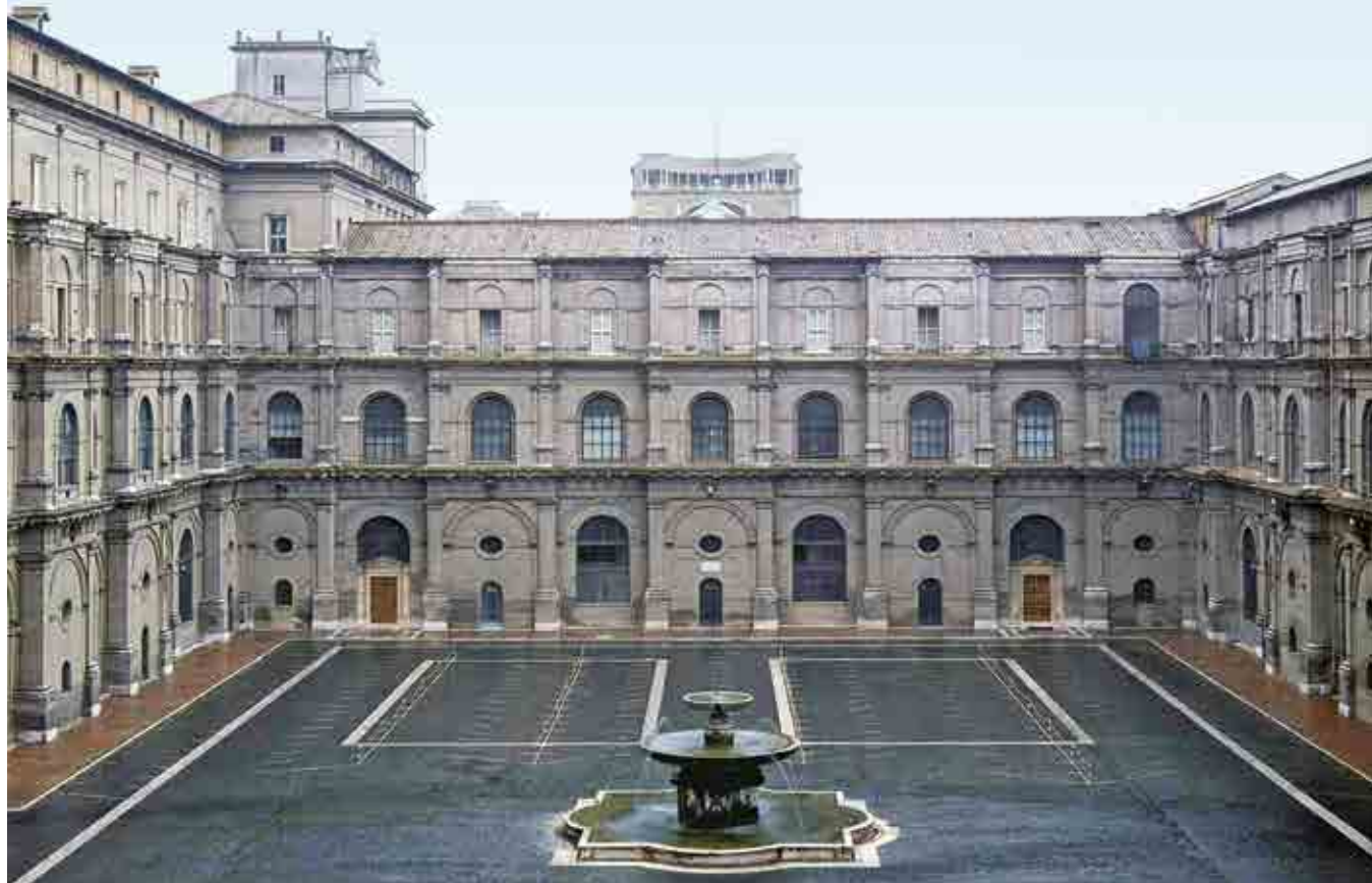
Cortile del Belvedere con la Biblioteca di Sisto V; al piano terra gli ingressi della Biblioteca (destra) e dell'Archivio (sinistra) aperti da Pio XI.
